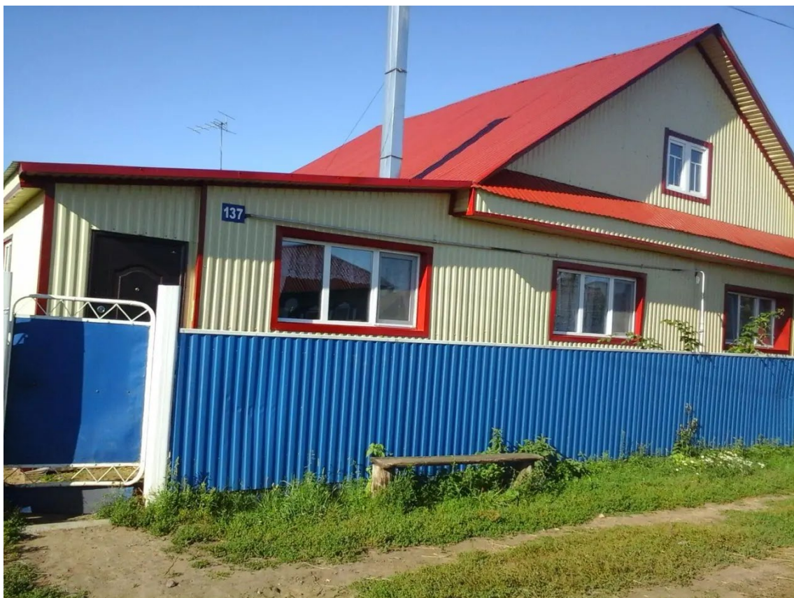
Дом Янгировых в д. Арсланово
